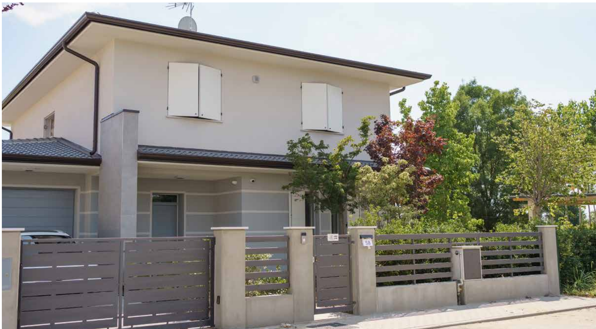
Mirandola (Mo). Abitazione unifamiliare, Bosco 8
