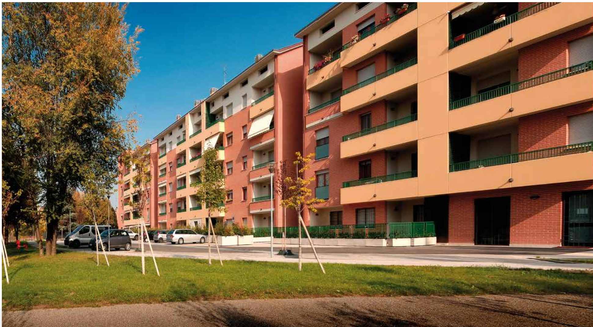
Modena. Complesso residenziale PEEP
